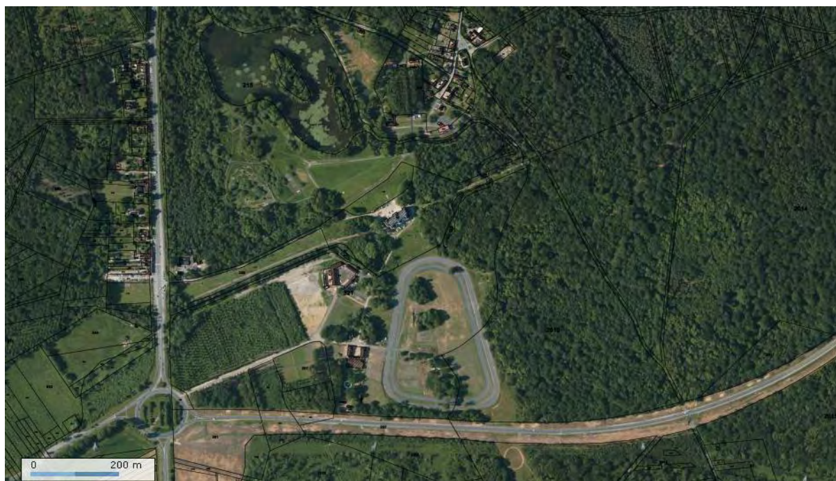
Vue aérienne de la zone 2 AUt
