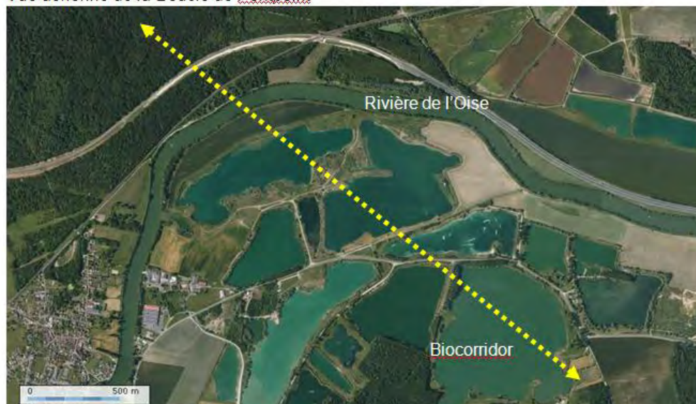
Vue aérienne de la Boucle de Pontpoint
